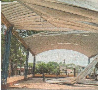
Foto 1: Lámina de techo de cancha polideportiva en mal estado, lado sur
