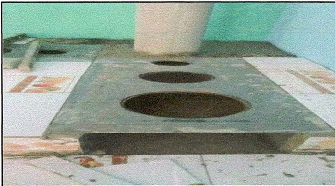
Foto 9: Sustitución de plancha de metal de 3 hornillas
