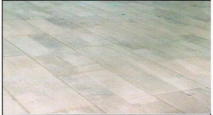
Foto 8: Sustitución piso de torta de cemento por cerámico.
