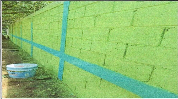
Foto 7: Pintura en muros exteriores e interiores
