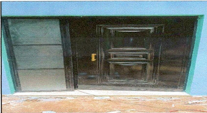
Foto 3: Sustitución de puerta
