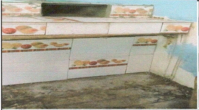
Foto 14: Reparación de azulejo en muebles de cocina
