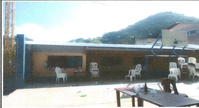
Foto1: Techo de lamina instalado
