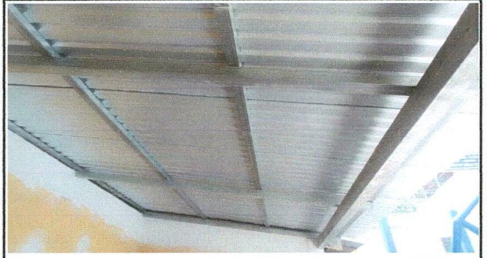
Foto 2: Estructura de metal instalado
