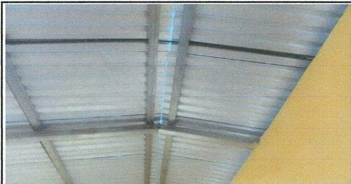
Foto 5: Cableado eléctrico instalado
