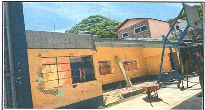
Foto 2: Eliminación de la madera del techo
