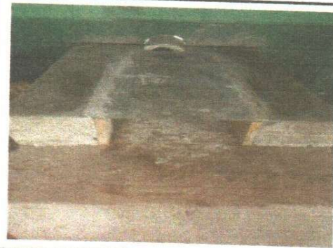
Foto 4: Sustitucion de plancha de metal en cocina
