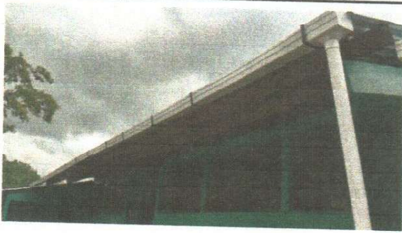
Foto 3: Sustitucion de bajadas de agua pluvial
