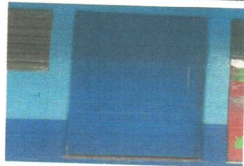
Foto 6: Sustitucion de puerta
