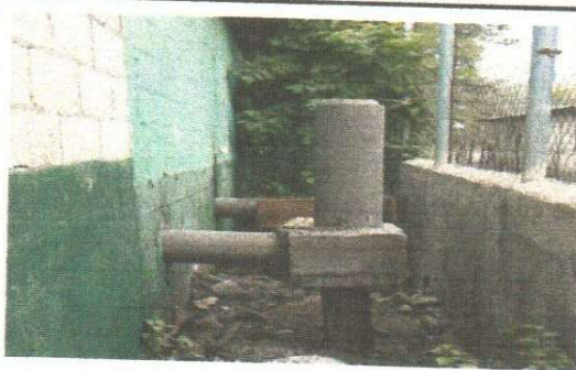
Foto 5: Sustitucion de chimenea de concreto
