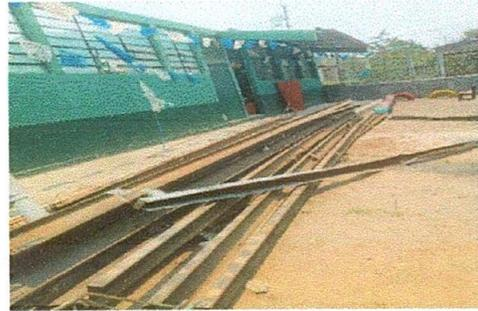
foto 2: Sustitucion de canales y soporte o pescantes
