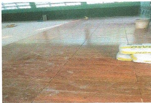
foto 9: Sustitucion de piso de torta de cemento por ceramica
