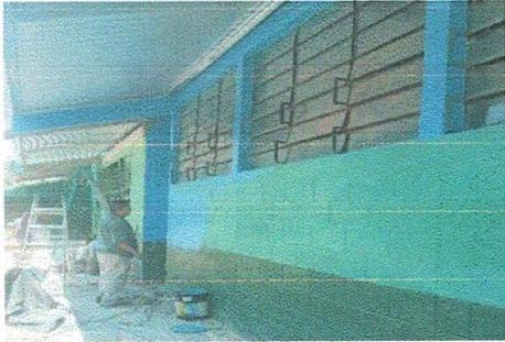
foto 7: pintura en muros interiores y exteriores
