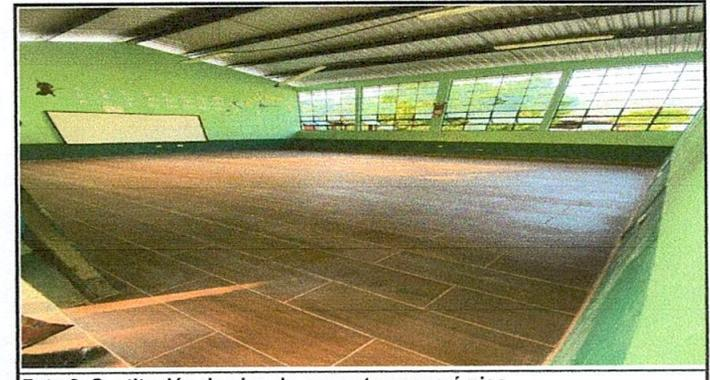
Foto 6: Sustitución de piso de concreto por cerámico.
