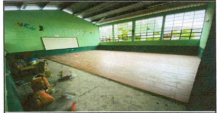
Foto 6: Sustitución de piso de concreto por cerámico.
