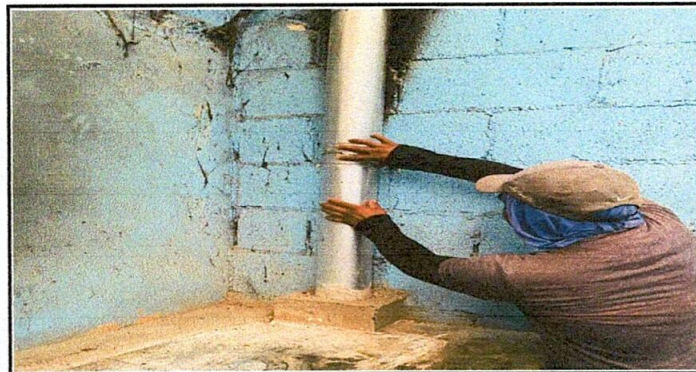
Foto 5: Sustitución de chimenea de metal.
