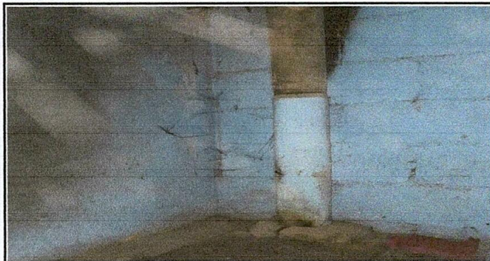
Foto 5: Sustitución de chimenea de metal.
