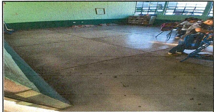
Foto 6: Sustitución de piso de concreto por cerámico.
