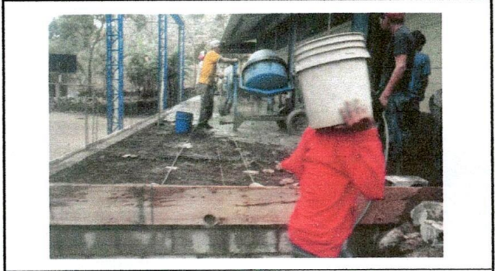
Foto 2: Trabajo en proceso de la sustitución de piso de torta de concreto
