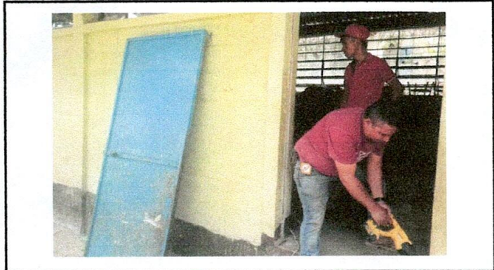
Foto1: Se procede a sustituir las puertas
