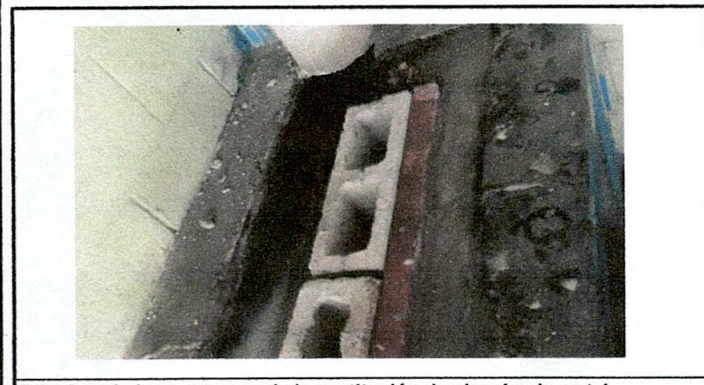
Foto 5: trabajo en proceso de la sustitución de plancha de metal
