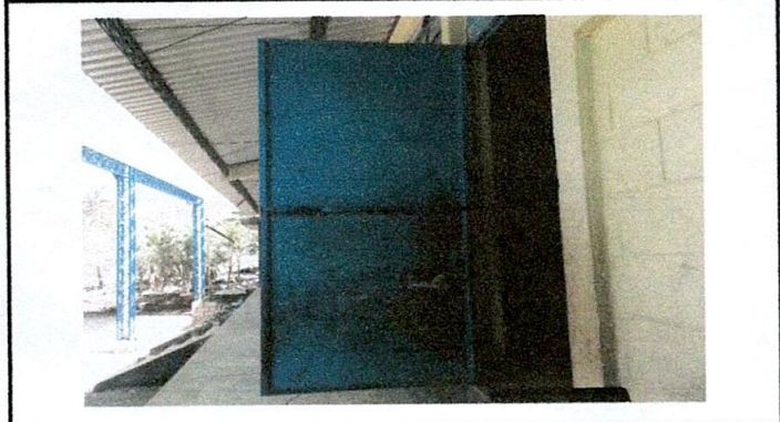
Foto 1: Sustrucción de puertas
