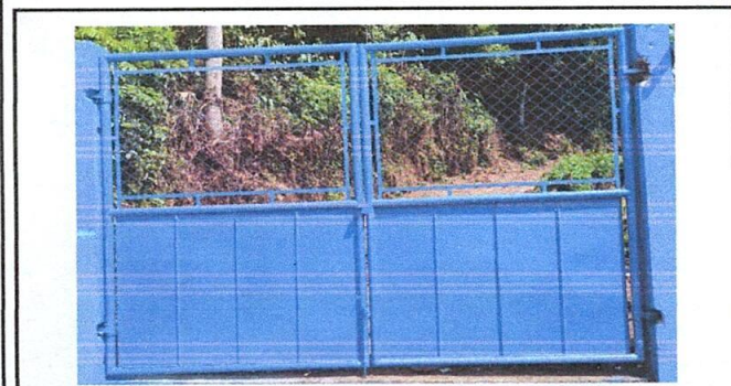
Foto 5: Sustitución de porton de metal
