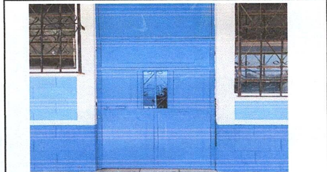
Foto 4: sustitución de puerta de metal
