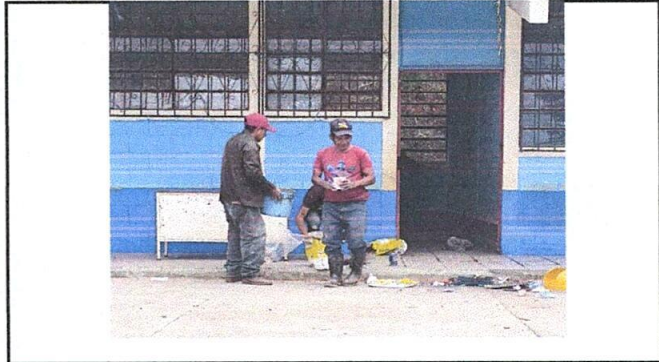
Foto 2: Aplicación de pintura
