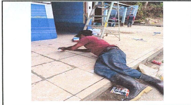
Foto1: sustitución de piso Cerámico
