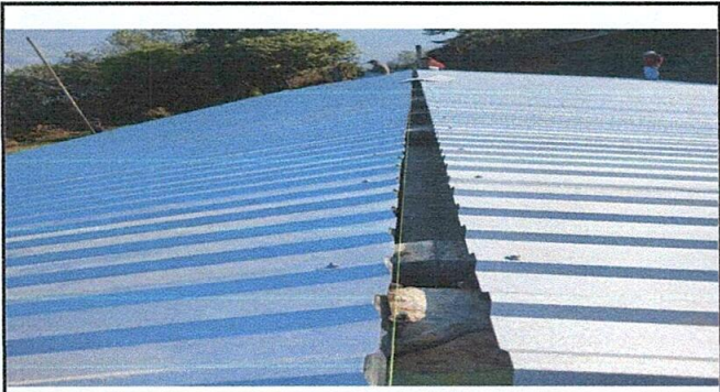
Foto1: techo de la escuela
