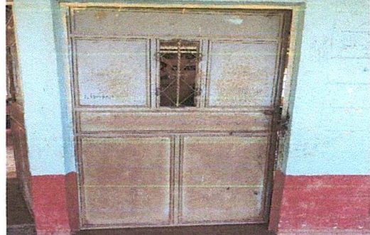
Foto 2: puerta de una de las aulas
