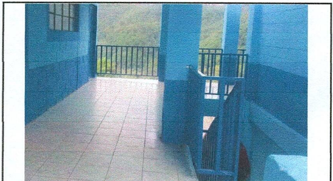
Foto 4: Barandas del segundo nivel instaladas.
