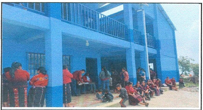
Foto 6: Finalización del proceso de mantenimiento
