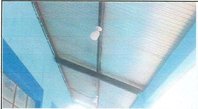
Foto 3: Plafoneras, focos y cableado sustituidos.
