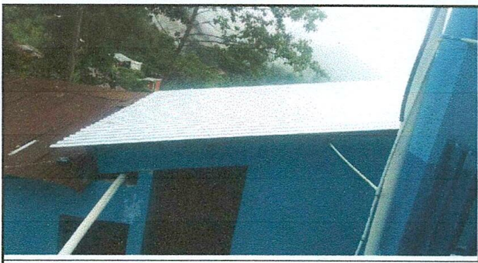
Foto 5: Techo de lámina sustituida
