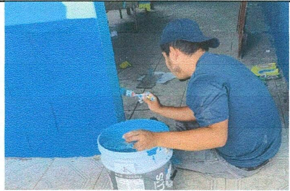
Foto 2: Aplicación de pintura en interiores y exteriores
