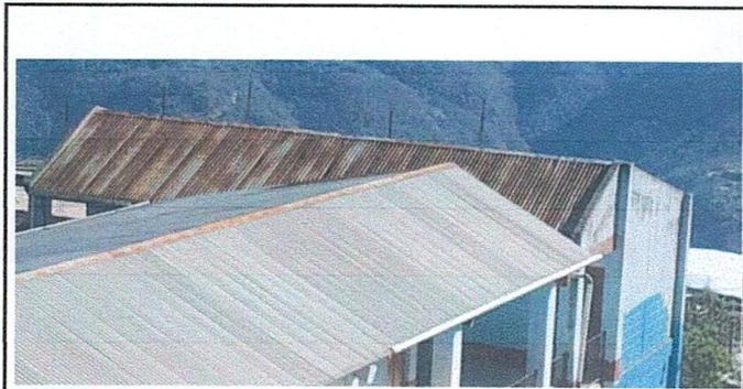
Foto 3: Cubierta de lámina en mal estado, lo cupal será sustituida.
