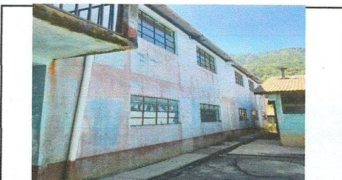
Foto 6: Pintura en muros exteriores e interiores en muy mal estado
