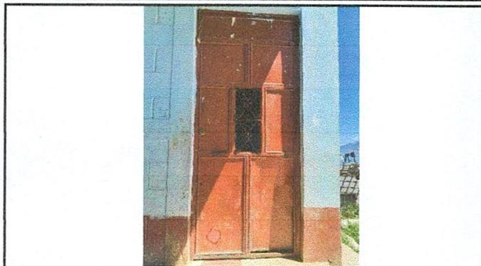
Foto 1: Puertas deterioradas por oxido.
