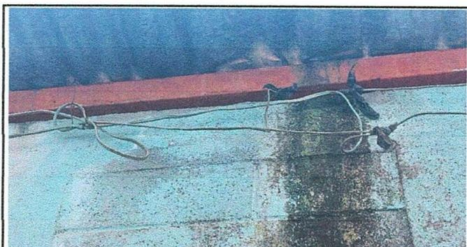
Foto 4: Sistema electrico, cables en mal estado.
