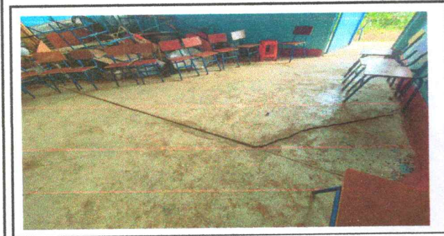
Foto 5: reparación de piso de torta de concreto
