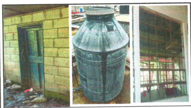
Foto : Sustitución de puerta, tinaco y ventana en mal estado
