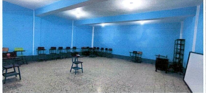
Foto 2: Pintura de muros interiores
