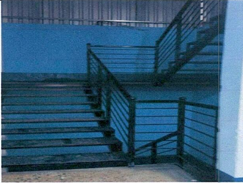
Foto 1: Instalación de estructura portante de metal
