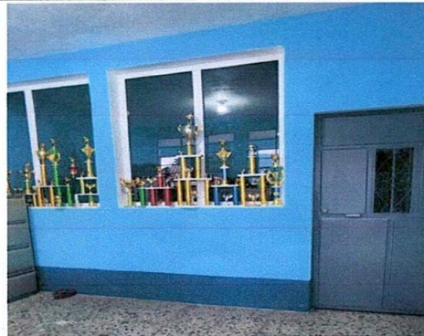
Foto 4: Puertas y ventanas
