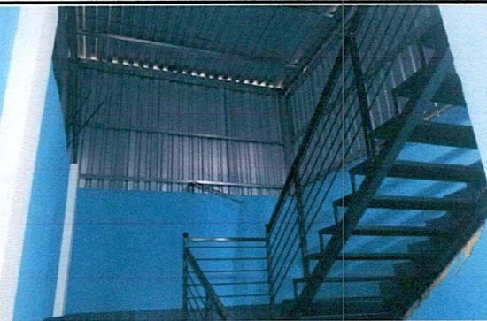
Foto 5: Cubierta de lamina
