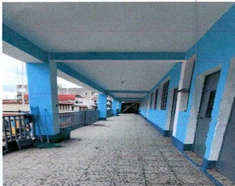
Fotos 3: Pintura de muros exteriores
