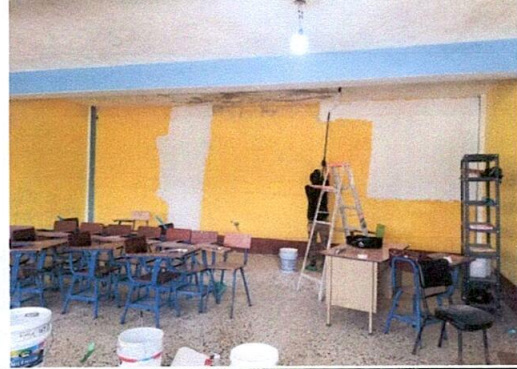
Foto 2: Impermeabilización de pared
