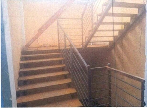
Foto 1: Instalación de estructura portante de metal
