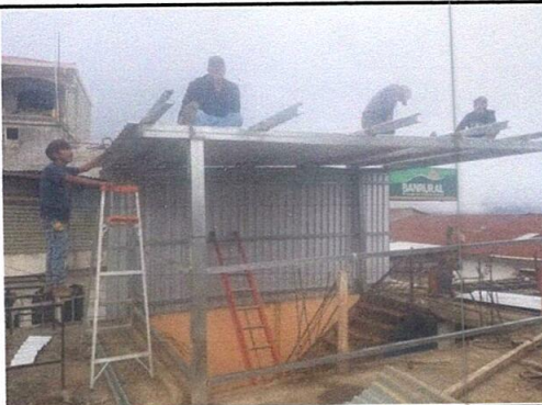
Foto 5: Colocación de cubierta de lamina
