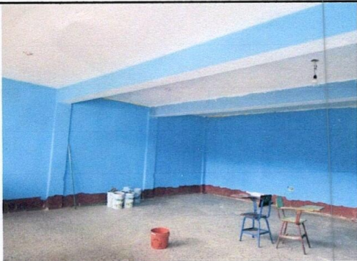
Foto 3: Pintura en muros interiores
