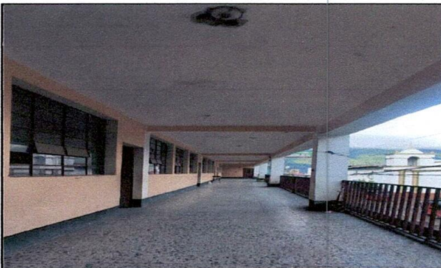
Foto 3: Pintada de paredes
