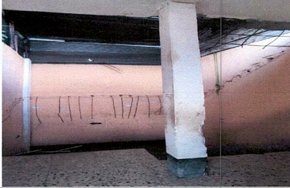
Foto 1: Instalación de estructura portante de metal
