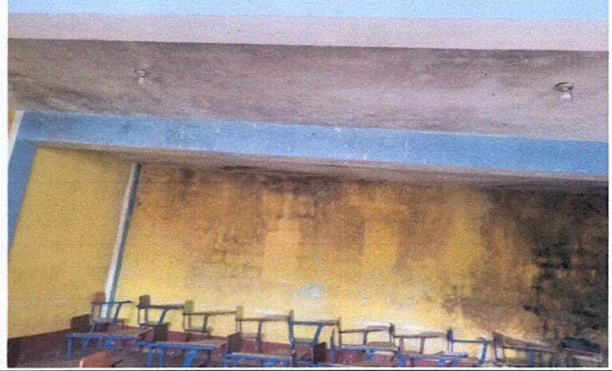
Foto 2: Impermeabilización de pared
