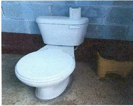
Foto 3: Baños nuevos instalados.
