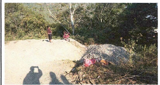
Foto 1: Preparando el material para fundir.
