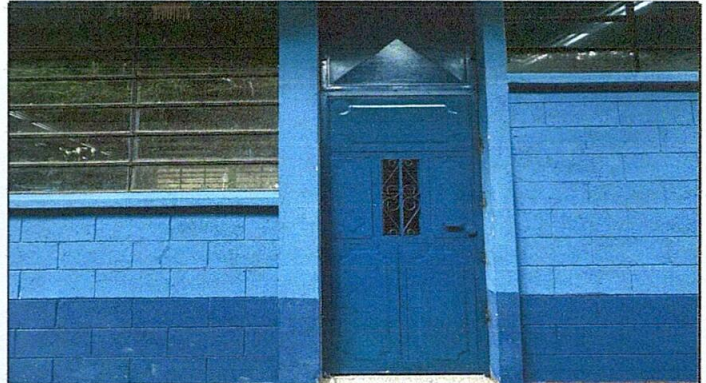
Foto 2: Sustitución de puertas de metal.
