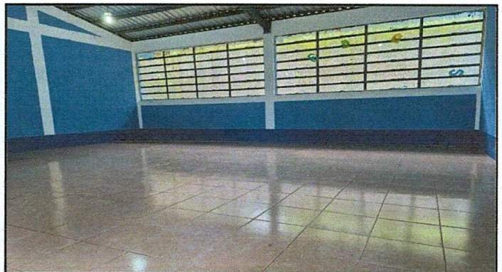
Foto 4: Sustición de piso cerámico.
