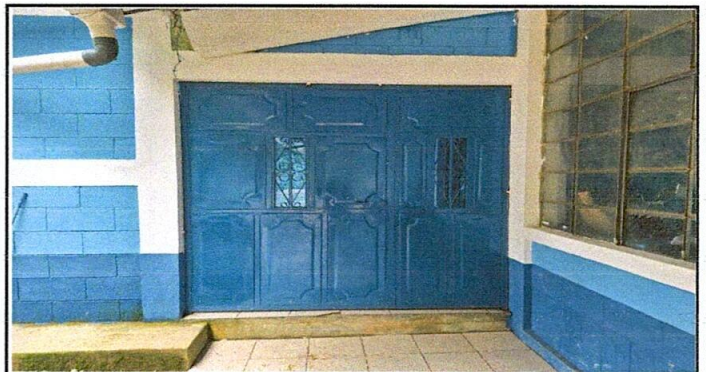
Foto 6: Sustitución de portón de metal.
