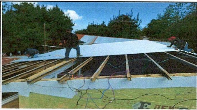
Foto 3: Colocación de láminas troqueladas calibre 24.
