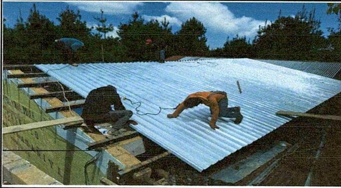
Foto1: Colocación de láminas troqueladas calibre 24..
