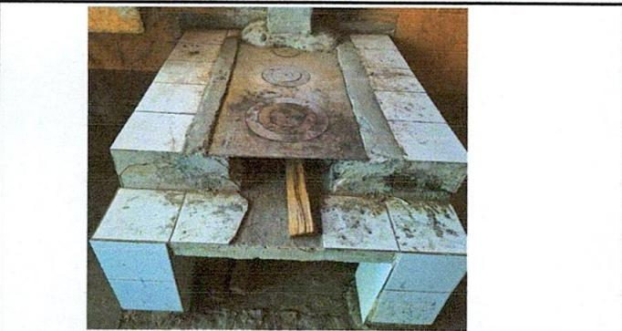
Foto 5: Sustitución de plancha de cocina.
