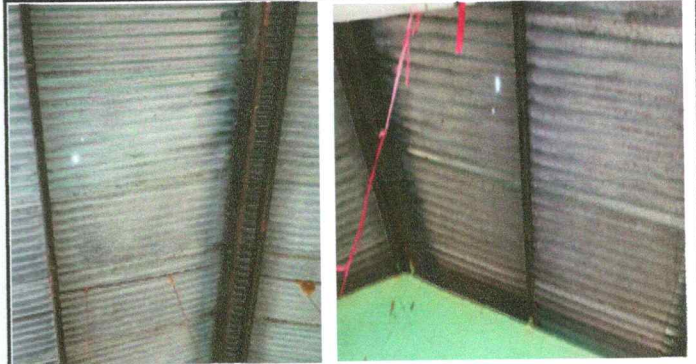
Foto 2: Mantenimiento a estructura de soporte de metal
