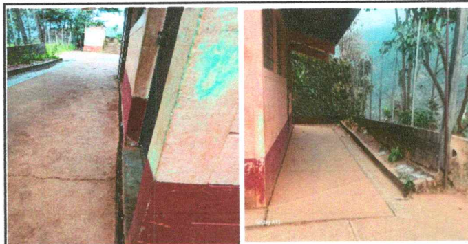
Foto 11: Sustitucion de piso de torta de concreto.
