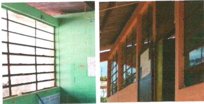
Foto 5: Mantenimiento a estructura de metal de ventanas
