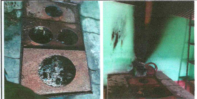
Foto 12: Sustitucion de plancha de metal de 3 hornillas y chimenea de metal.
