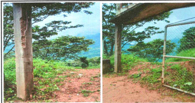
Foto 9: Sustitucion de portón de metal.
