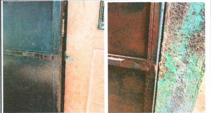
Foto 10: Sustitucion de chapas.
