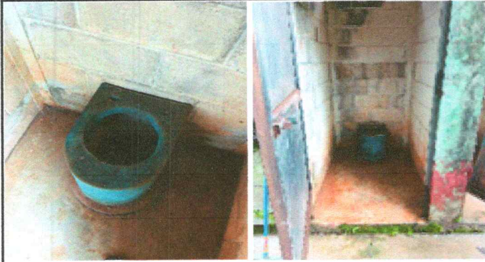
Foto 7: Sustitucion de inodoro y de accesorios contra llave, tubo de abasto y tanque.
