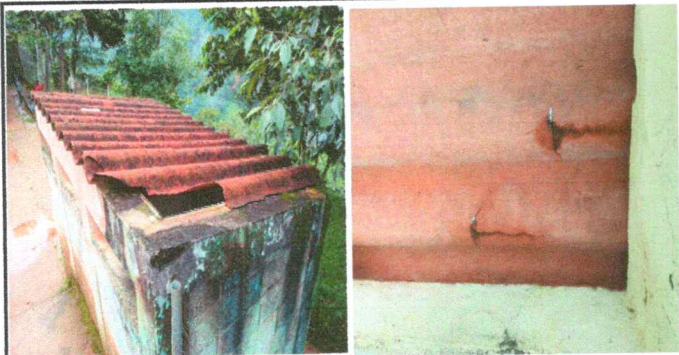
Foto 3: Sustitucion de techo por lamina troquelada calibre 26. y de estructura de soporte de metal (Servicios sanitarios)
