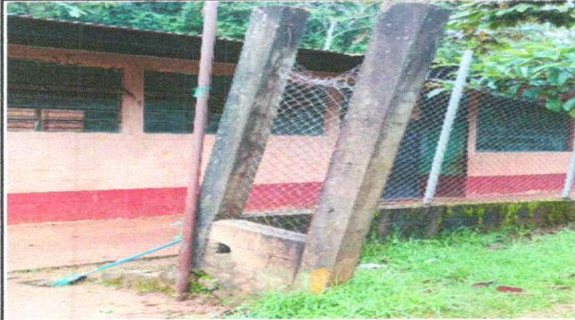
Foto 13: Sustitución de muro perimetral de block con tubo hg y malla galvanizada, soleras intermedias y columnas.
