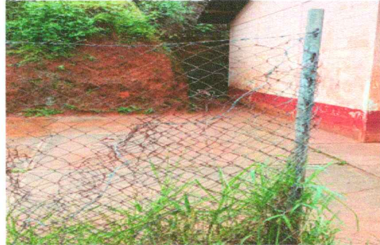
Foto 14: Sustitución de muro perimetral de block con tubo hg y malla galvanizada, soleras intermedias y columnas.
