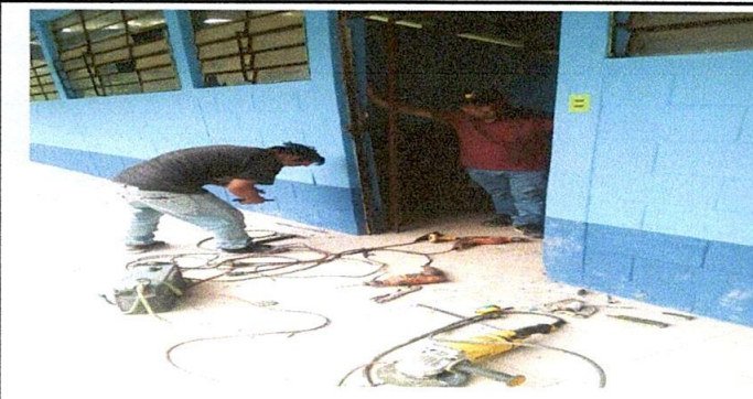
Foto 5: Instalacion de puertas
