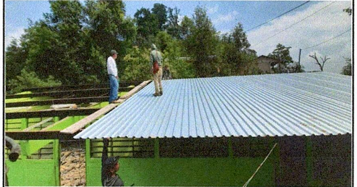
Foto 2: Llegando a las mitad de la colocación del nuevo techo
