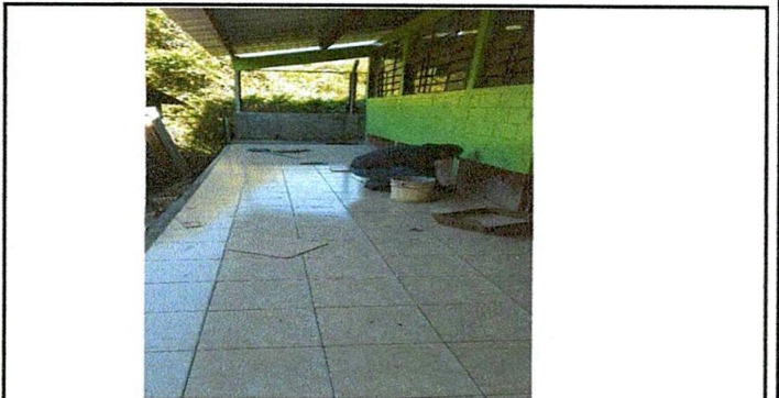
Foto 6: Finalización pegado de cerrámico
