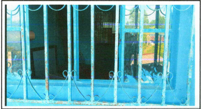
Foto7: Sustrucción de de estructura metal de ventanas
