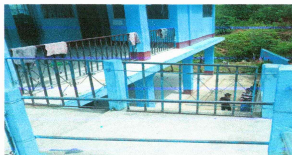
Foto 6: Sustitución de barandas
