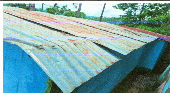
Foto1: Sustitución de láminas
