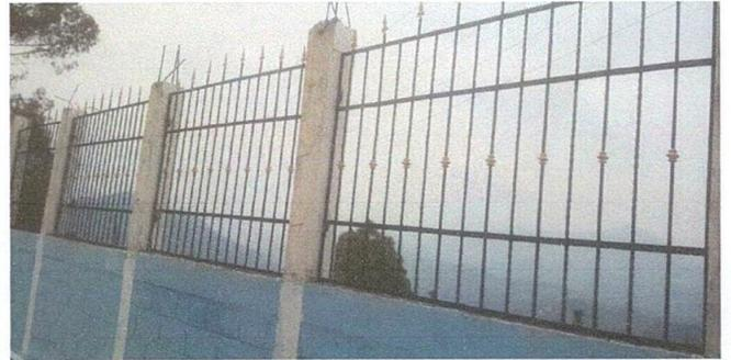
Foto 2: Sustitución de malla por varanda
