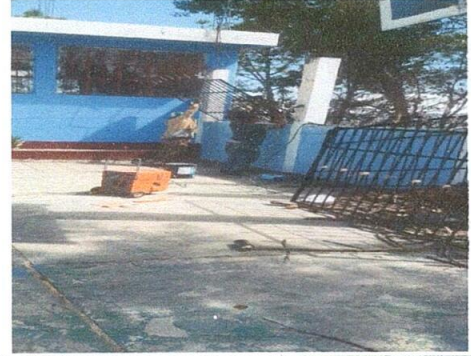
Foto 2: Sustitución de malla por varanda
