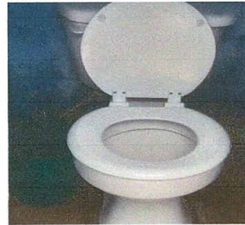
Foto 4: Sustitución de accesorios y tapa de sanitario
