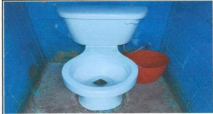
Foto 4: Sustitución de accesorios y tapa de sanitario
