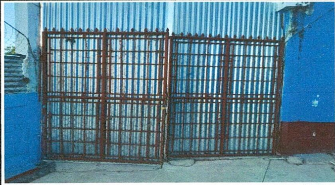
Foto 1. Sustitución de porton
