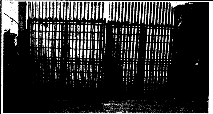
Foto 1. Sustitución de porton
