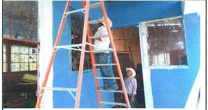
FOTO 2 5 VENTANAS Sustitución de ventanas de metal a ventanas de PVC
