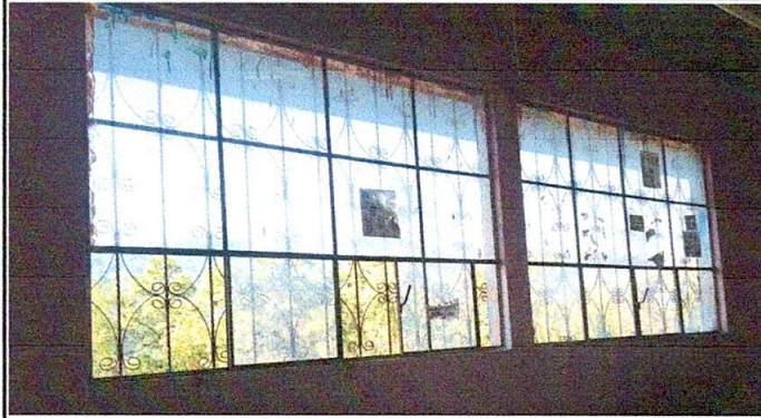
FOTO 1 5 VENTANAS Sustitución de ventanas de metal a ventanas de PVC
