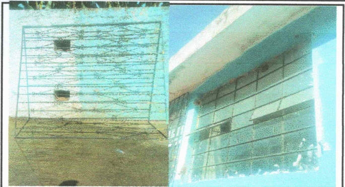
Foto 2: Mantenimiento a balcones de metal ( soldaduras, lijada y pintada )
