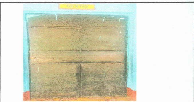
Foto 5: Mantenimiento para puertas de las aulas y bodegas ( lijado y aplicación de pintura)
