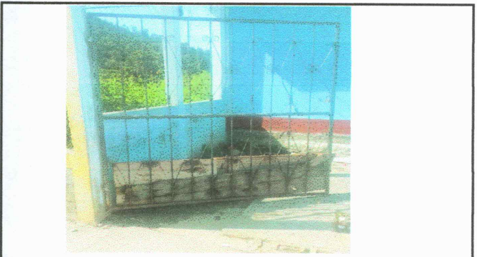
Foto 4: Mantenimiento a porton de metal
