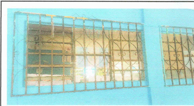
Foto1: Sustitución de ventanas
