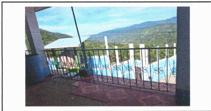
Foto 5: Mantenimiento de barandas.
