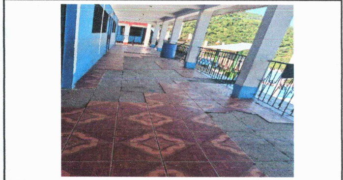
Foto 4: reparación de piso de aulas y corredor
