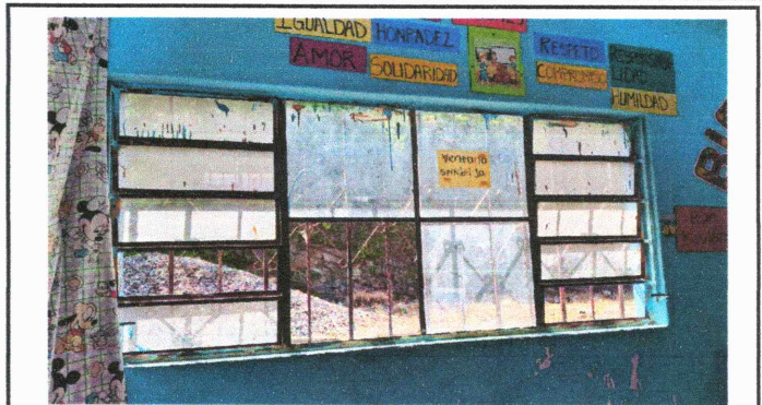
Foto 2: Reparación de ventanas
