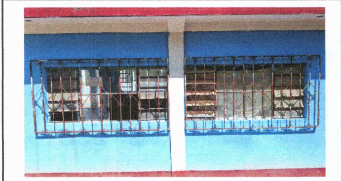
Foto 3: Reparación de balcones
