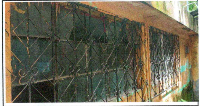
Foto 2: CAMBIO DE VENTANAL
