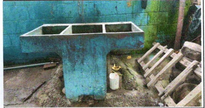
Foto 4: CAMBIO DE PILA DE CEMENTO
