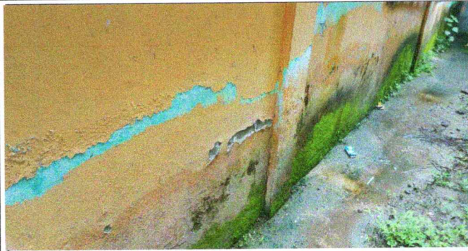
Foto 1: REPELLADO DE PARED
