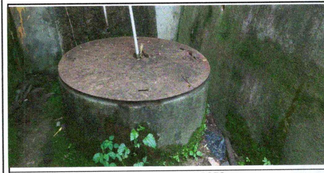
Foto 5: CAMBIO DE BOMBA ELECTRICA DE POZO
