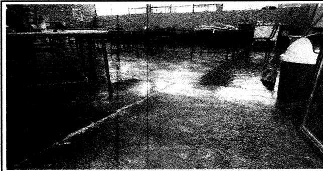
Foto 9: Sustritiución de Piso
