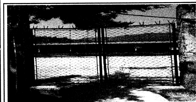
Foto 5: Sustitución de Portón
