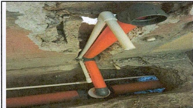
Foto 3 Sustitución tubería de Drenaje y agua en servicios sanitarios
