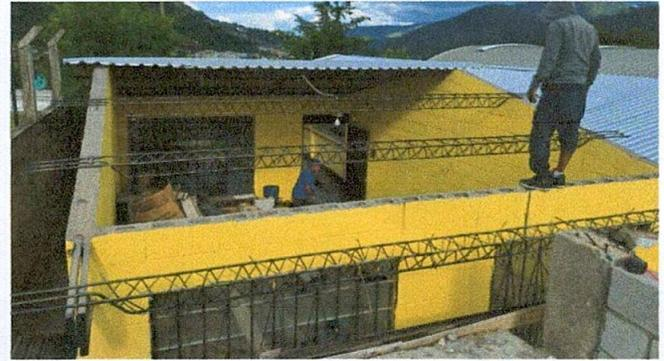
Foto 2. Sustitución de Lámina Aulas módulo I
