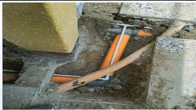
Foto.3 Reparación sistema de drenaje y agua servicios sanitarios
