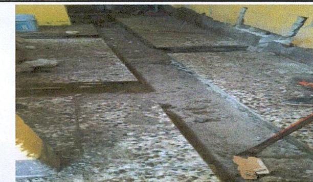
Foto 5. Reparación de piso dañado en servicios sanitarios
