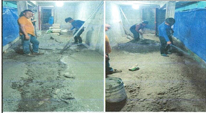
Foto No. 7 Se observa que esta colocando el piso de concreto tipo torta en la bodega del centro educativo.
