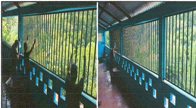
Foto No. 3 se observa que se esta colocando las barrandas en el corredor del centro educativo para evitar accidentes en los estudiantes
