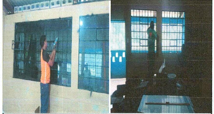
Foto No. 2 Se esta trabajando la colocación de los vidrios de las ventanas de las aulas en el centro educativo.
