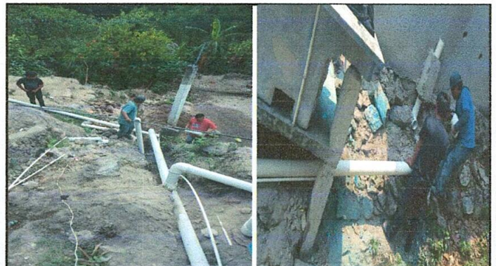
Foto No. 4 En estas imágenes se observa que se esta colocando las nuevas tuberías de alta presión que durará muchos años.
