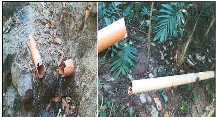
Foto No. 4 La tubería de drenaje estan quebradas.
