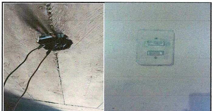
Foto No. 6 Los apagadores o switch estan en mal estado así mismo las plafoneras ya estan quebradas.
