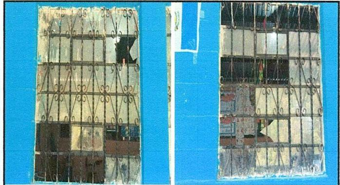
Foto No. 2 Los vidrios de las ventanas estan quebradas y manchadas
