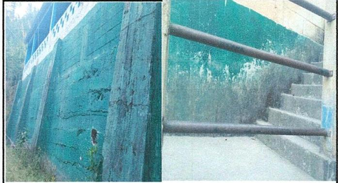
Foto No. 8 La pintura del muro y las paredes del centro educativo estan en mal estado.
