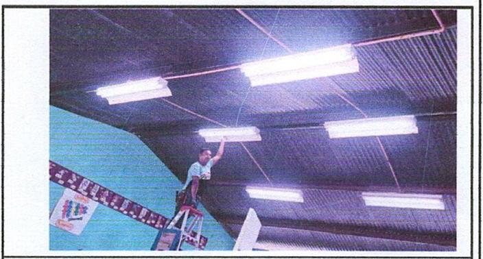
**Foto 6. Sustitución de sistema eléctrico, por lamparas LED**
