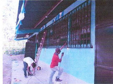
Foto 8. Fabricación e instalación de balcones de hierro en ventana.
