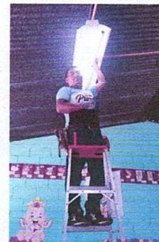
Foto 6. Sustitución de sistema eléctrico, por lamparas LED
