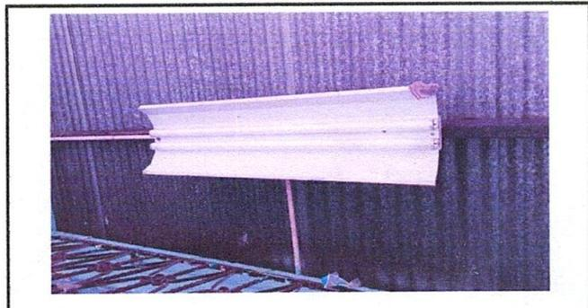
**Foto 6. Sustitución de sistema eléctrico, por lamparas LED**
