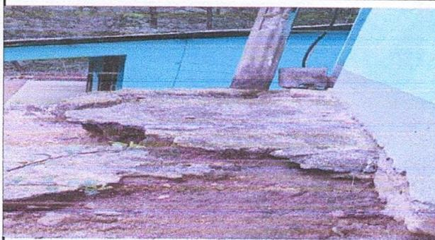
Foto 9. Reoaración de piso de torta de concreto, esta en mal estado
