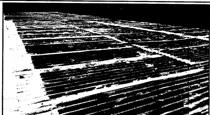
Foto 2: Laminas en mal estado y deteriorado
