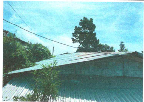
Foto 2: Techo de lamina
