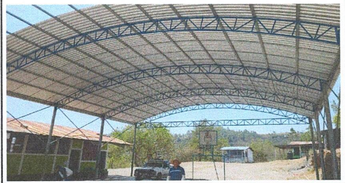
Foto 2: INSTALACION DE LAMINAS
