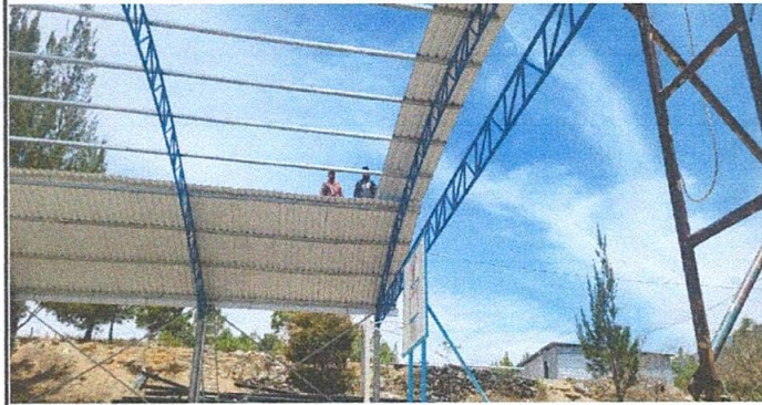
Foto1: INSTALACION DE LAMINAS
