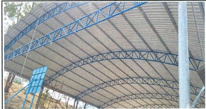
Foto 3: FINALIZACION DE LOS TRABAJOS
