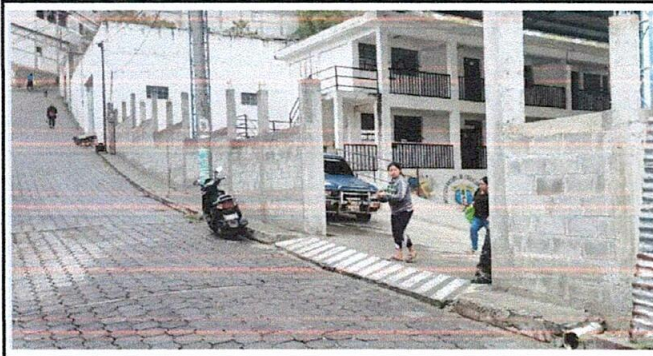
Foto 1: Sustrucción de muro perimetral terminado
